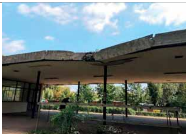
1.7. ábra: A tetőszerkezet leromlott állapota
